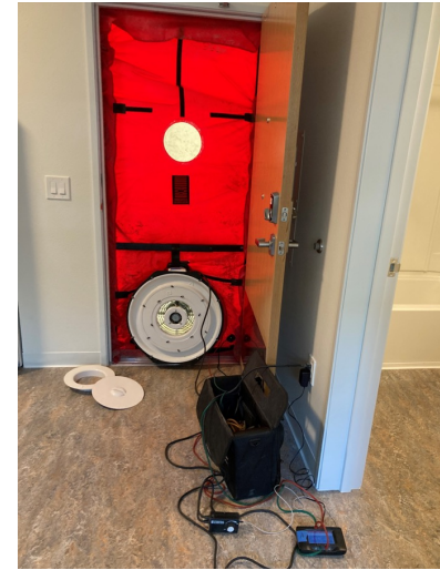
Blower door test set-up
